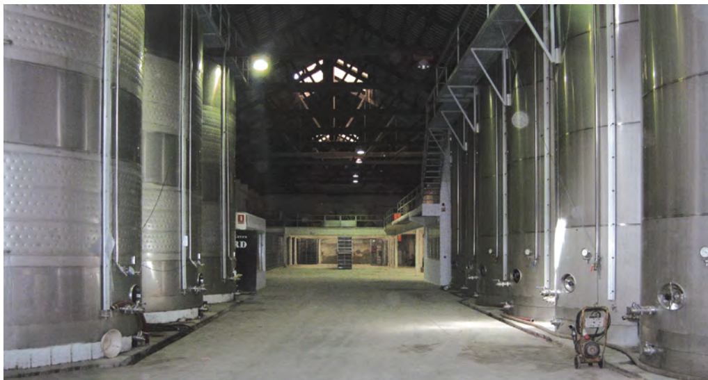
Vistes de l'interior i exterior després de la reforma.
